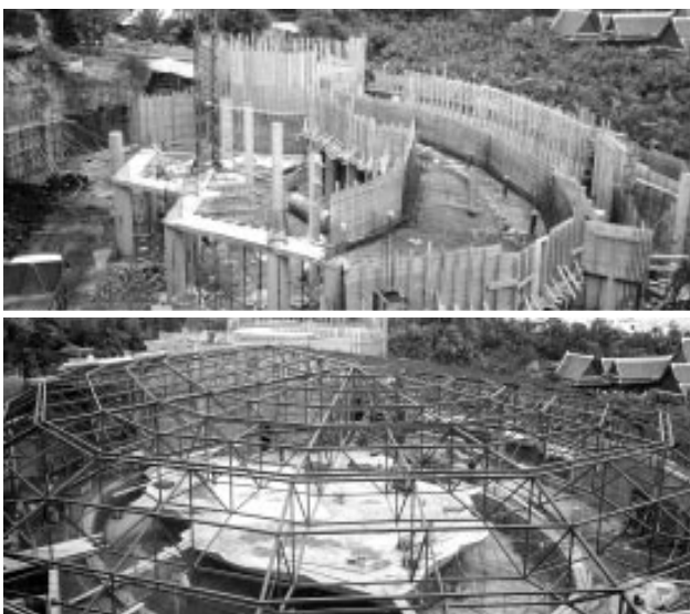
Dos momentos de los trabajos de construcción vistos desde arriba.
