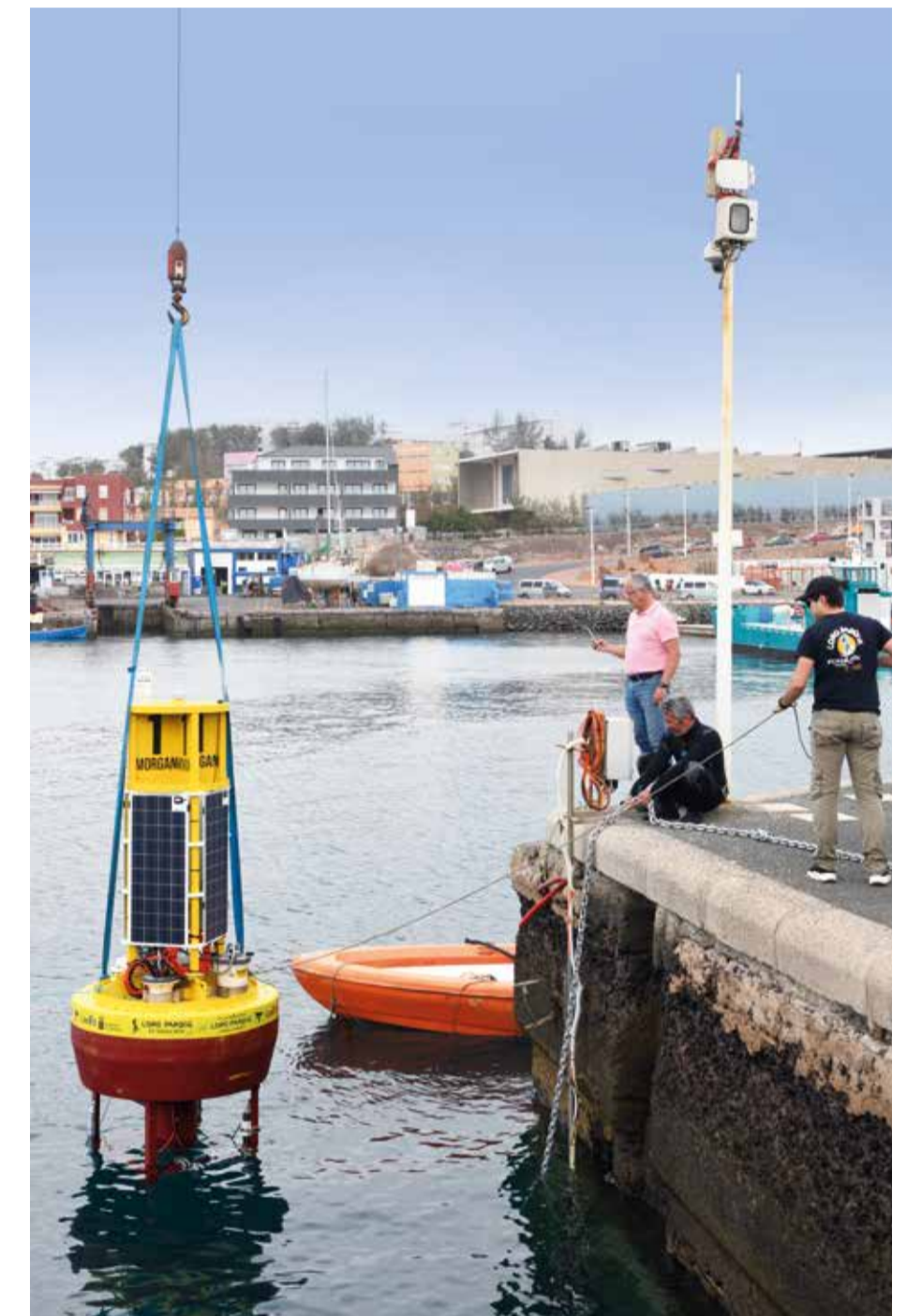
Instalación inicial de la boya en el muelle de Taliarte para la fase de prueba y verificación de los instrumentos científicos y las comunicaciones. Fotos: M. Pérez / LPF
